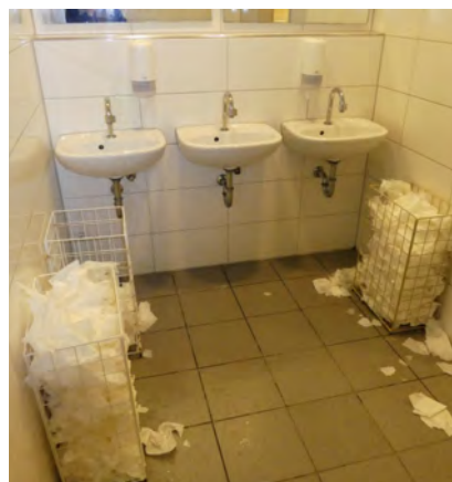
Situation in den Herrentoiletten im Altbau, Erdgeschoss
